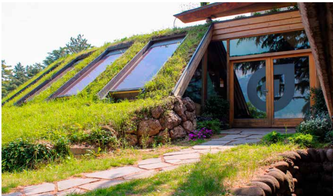
L'ingresso della sede trentina di ETC Engineering
