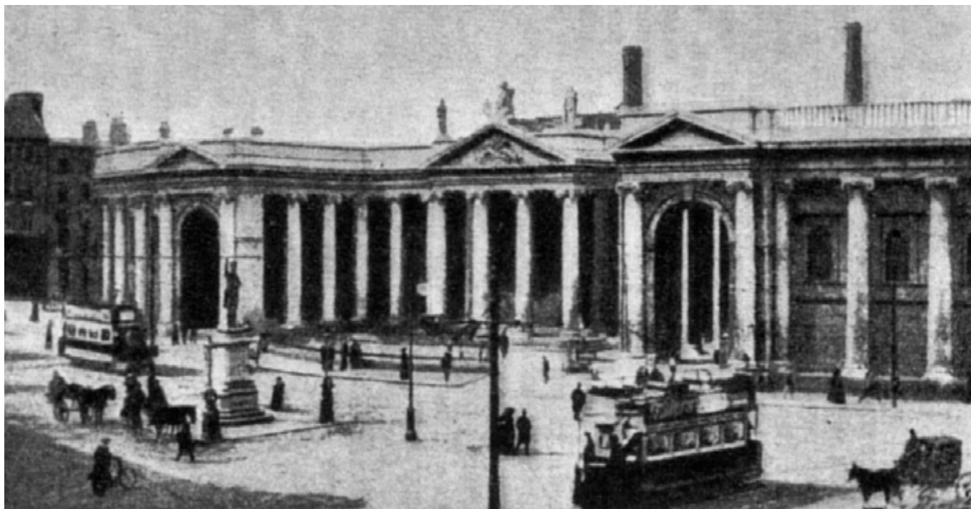
Foto storica della Bank of Ireland (Dublino)
